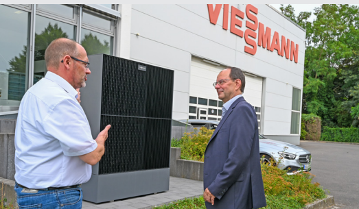
Wärmepumpe an der Viessmann-Niederlassung in Troisdorf
