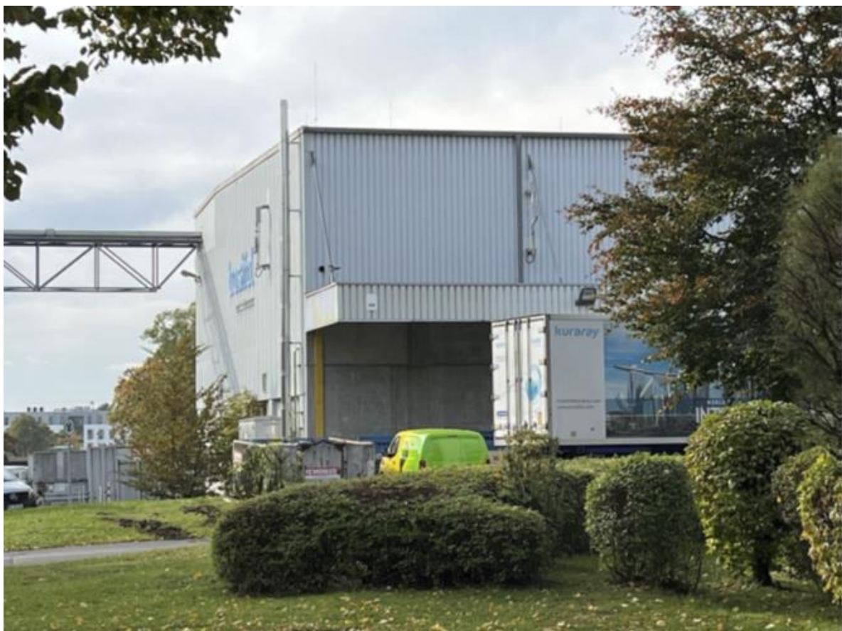
Abbildung 17: Antennen am Gebäude 288
