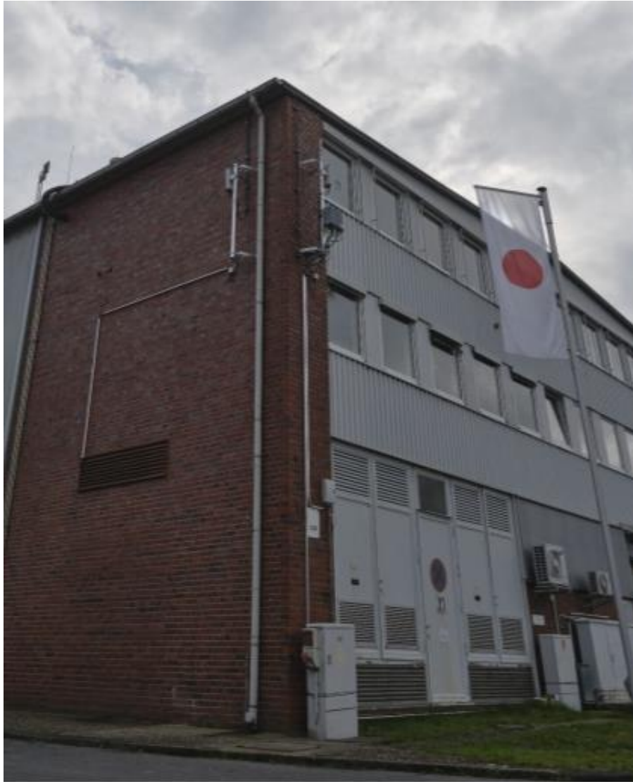
Abbildung 18: Antennen am Gebäude 226
