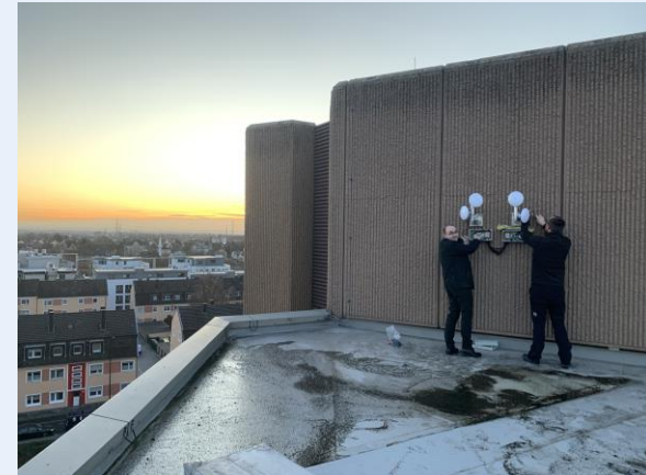
Installation der Richtfunkantennen auf dem Dach des Rathauses
